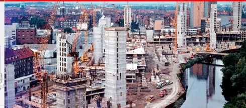
Baustelle Ihme-Zentrum Richtung Spinnerei-Brücke
