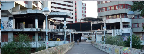
Provisorische Fuß- und Radwegeverbindung, Einfahrt Ida Arenhold-Brücke
