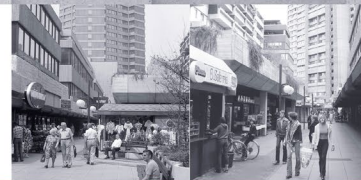
Ladenpassage Richtung Küchengarten 1977
