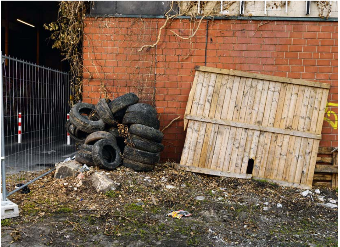
↑ Eingang Tunnel aus Richtung Blumenauer Straße, Frühjahr 2020 Foto: © PFADFINDER
